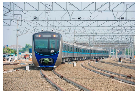
ジャカルタ 都市高速鉄道南北線
